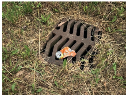
Entwässerungsschacht im Wald
